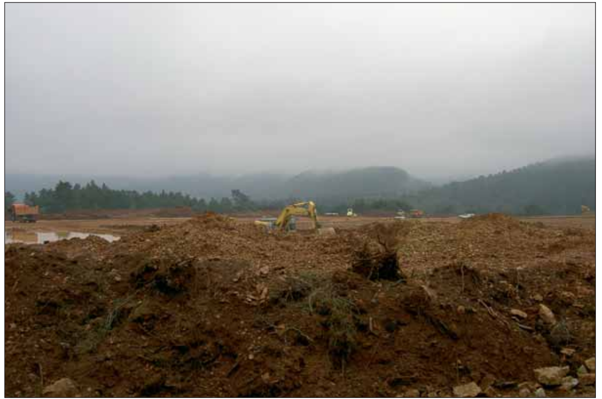
Movimiento de tierras en la balsa de Bóveda
